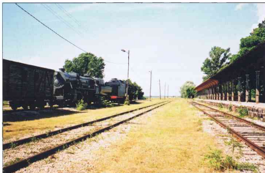
Järnvägmuseet med den 200 meter långa perrongen med trätak.
