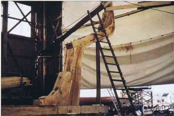
Hösten 1971 påbörjades byggandet av minsveparen M 31 Gåssten vid Knippla Skeppsvarv. Här har akterstävans rests.
