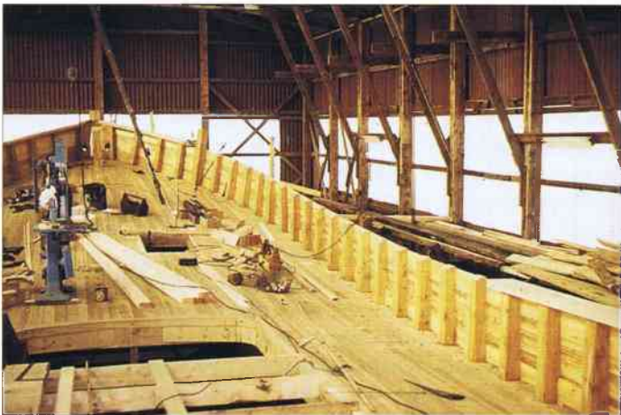
Däcket är nu inlagt och brädgången är på plats.
