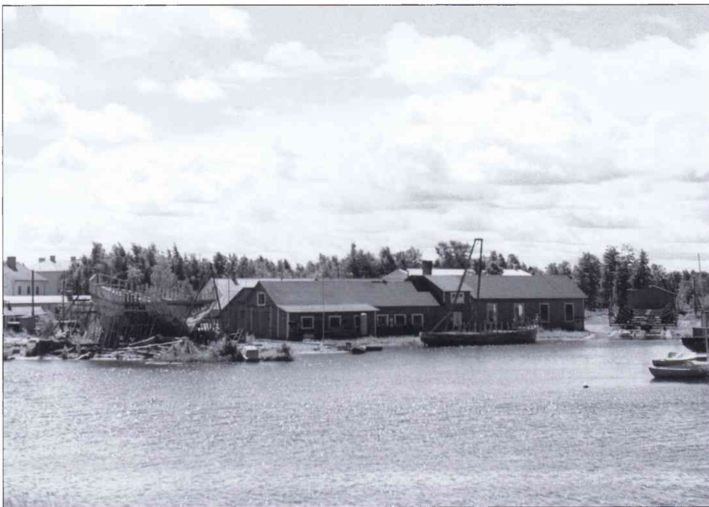
Rödösunds båtvarv år 1952. På fartygsbädden till vänster ligger ett ryskt fiskefartyg under byggnad. Detta blev senare GG 218 Västfjord från Fotö. Foto Curt S Ohlsson.
