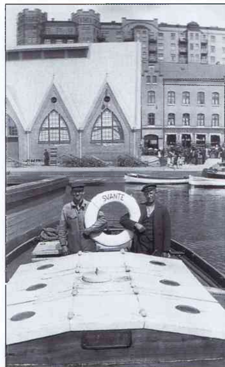
På byggnadsskylten på kappen står: Skandiaverken AB Lysekil 1924. Personerna från vänster är motormannen Birger Rörberg och Erik Öst.
