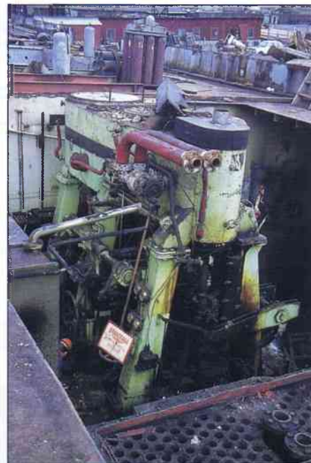
Monarda under upphuggning av Stena vid Hamnens varv i april 1971. Här syns tydligt ångmaskinens placering i maskinrummet. Foto Bertil Söderberg.
