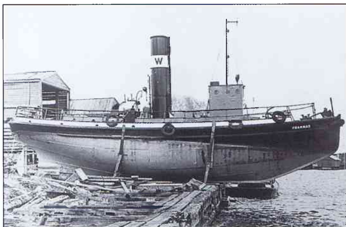
Isen har tagit hårt på skrovplåtarna trots täta spant. Foto från Lasse Petersson.
