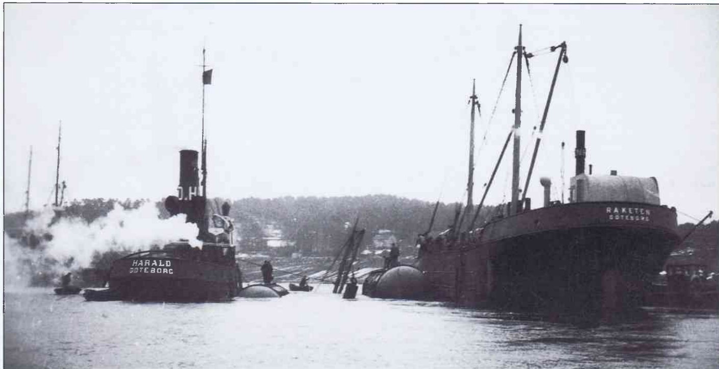
Röda Bolagets bärgningsångare Harald och läktaren Raketen med pontoner längsides färdiga att sänkas ned vid haveristen Vieille Montagne III den 10 december 1930. Arkivbild Bertil Söderberg.
