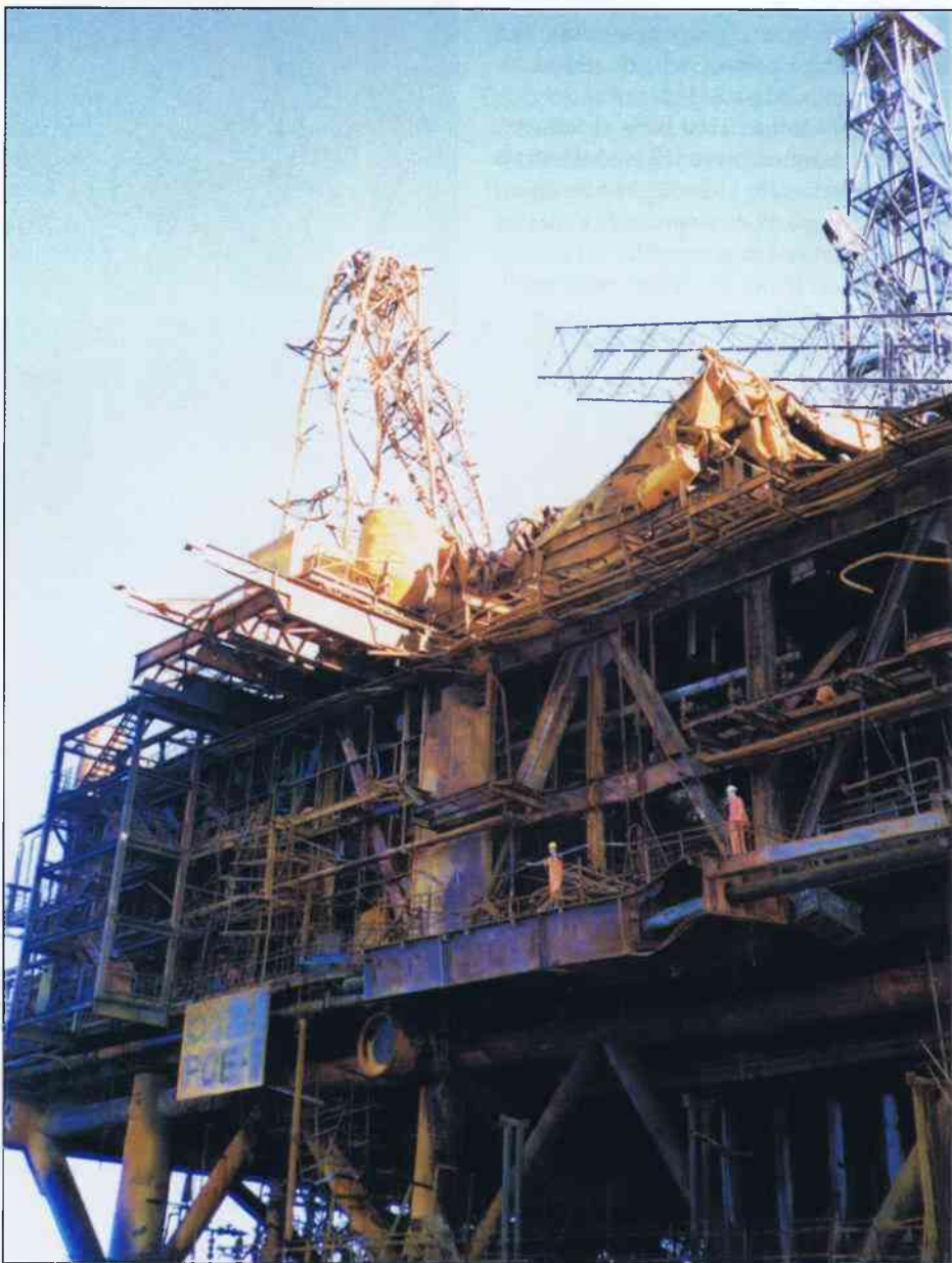
Nästan en månad efter branden startat, brast konstruktionen på Enchovas nedre däck och hon blev totalförstörd.
