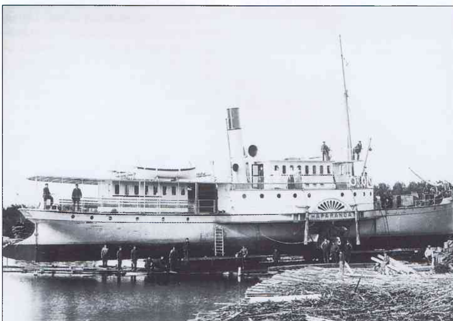
Denna bild av Haparanda på slip visar ångarens extrema grundgående. Foto från Norrbottens museum.
