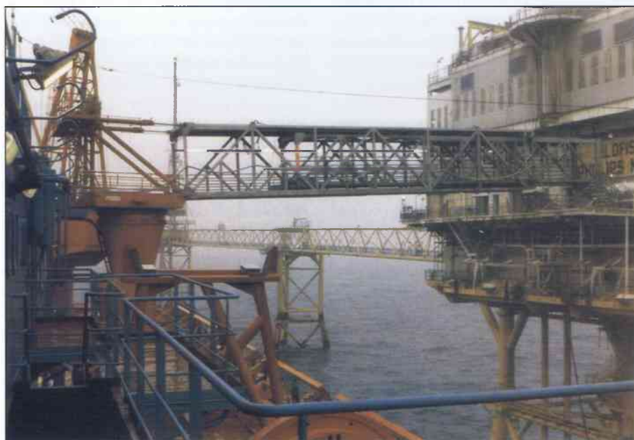
Landgångsförbindelsen med den bottenfasta installationen Eldfisk 2/7 FTP. Den viktigaste uppgiften oavsett väder och vind, var att försöka upprätthålla denna förbindelse.
